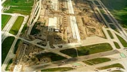
تقدم البناء في يونيو 1999 (منظر الجنوب الغربي)
